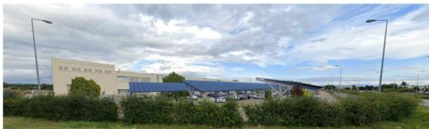
*Les panneaux photovoltaïques ont une capacité allant jusqu'à 1,2 MW en crête et produiront jusqu'à 1,3 GWh d'électricité par an.*
