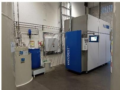
*L'évaporateur permet de traiter 1000 m<sup>3</sup> d'eau usée par an.*
